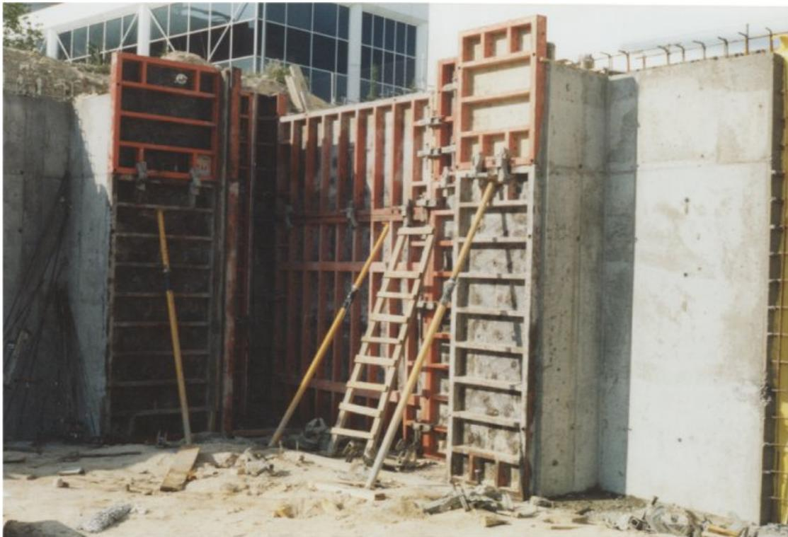
Fig. 41 Muros de sótano
