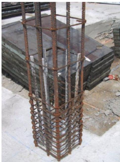
Fig. 2 Esperas de la zapata
