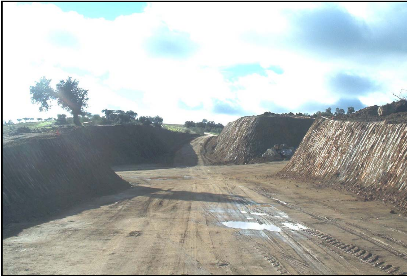
Refino de taludes
