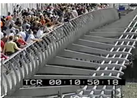
Pasarela del Milenio en Londres 2000
