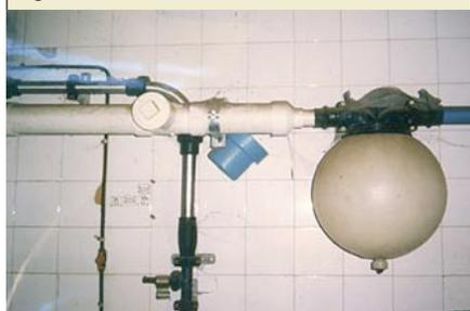
Por último, decir que las conducciones de vacío deben montarse con pendiente hacia el calderín de vacío o hacia válvulas de drenaje.
