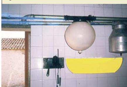
Del mismo modo, tampoco deben presentarse estrechamientos a lo largo de cualquier tubería. En la figura 21 se puede ver cómo disminuye el diámetro de la tubería para conectarse al calderín de vacío. Este montaje es inaceptable.
