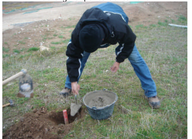
Se procede a verter el hormigón
