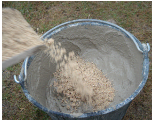
Se le añade arena para obtener el mortero
