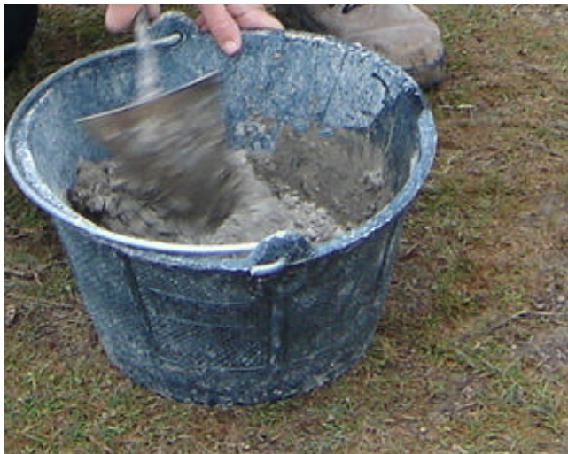
Se mezcla el cemento con el agua
