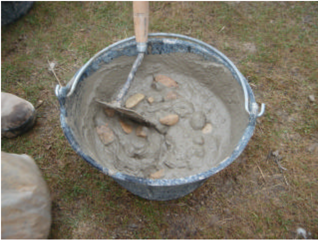
Se le añaden áridos (hormigón)
